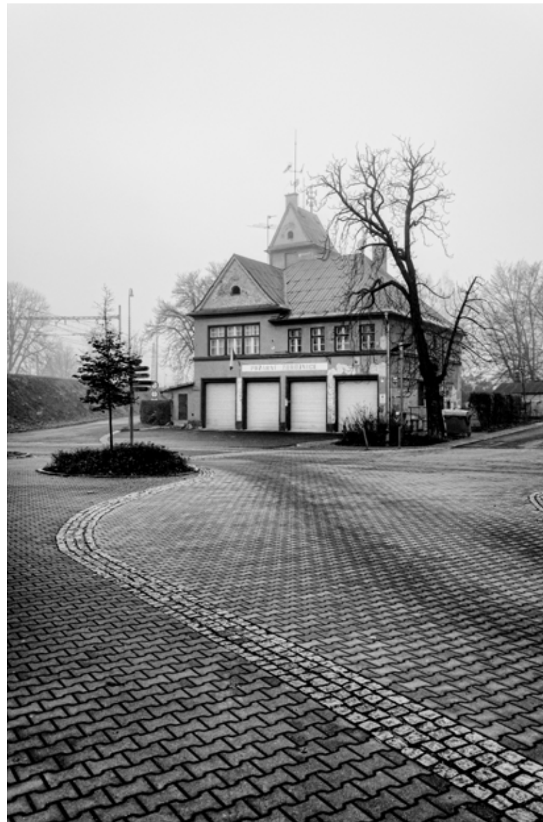
▲ ČESKÝ TĚŠÍN HASIČSKÁ STANICE POSTAVENA V ROCE 1931
